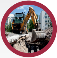
Korszerű távvezeték építése
